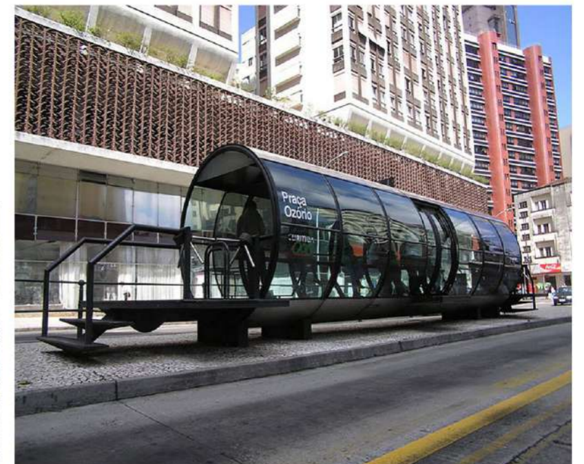
Las paradas o "estaciones tubo" de Curitiba son tubos de cristal y acero de 10 pies (3 m) de diámetro y una media de 10 m de largo, ubicadas cada 800 m aproximadamente. A ellos se accede por las escaleras que se encuentran en los extremos. A la entrada hay unos molinetes que sólo se activan tras el pago del billete, permitiendo así un acceso controlado del usuario y evitar el fraude.
