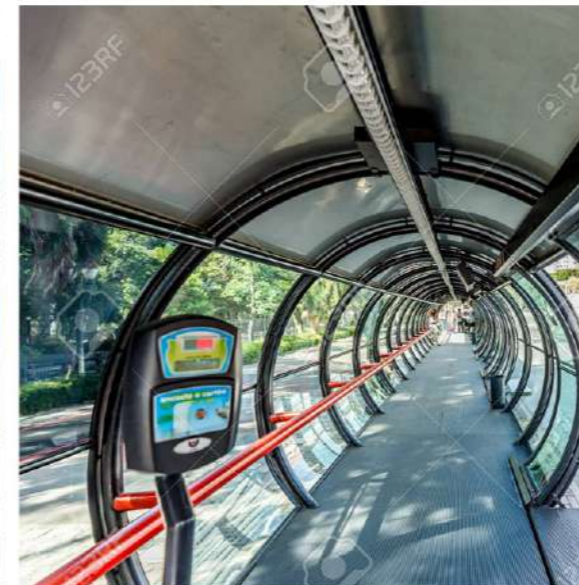
Las paradas o "estaciones tubo" de Curitiba son tubos de cristal y acero de 10 pies (3 m) de diámetro y una media de 10 m de largo, ubicadas cada 800 m aproximadamente. A ellos se accede por las escaleras que se encuentran en los extremos. A la entrada hay unos molinetes que sólo se activan tras el pago del billete, permitiendo así un acceso controlado del usuario y evitar el fraude.
