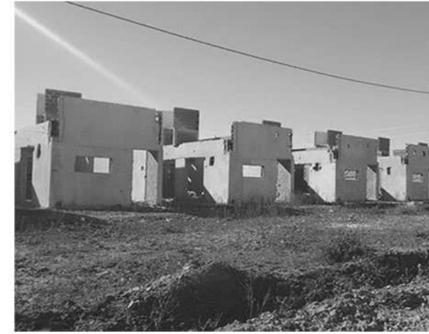
VIVIENDAS EN CONSTRUCCIÓN
