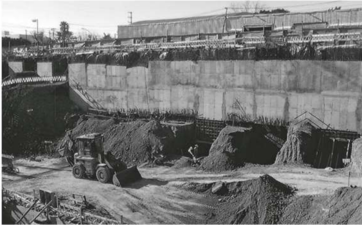
Movimiento de suelo y submuraciones
