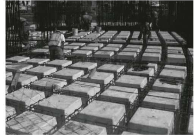
Armado losa aliviada casetonada
