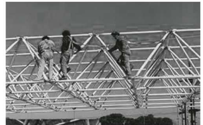
Soldadura de partes de la estereonestructura previo izado
