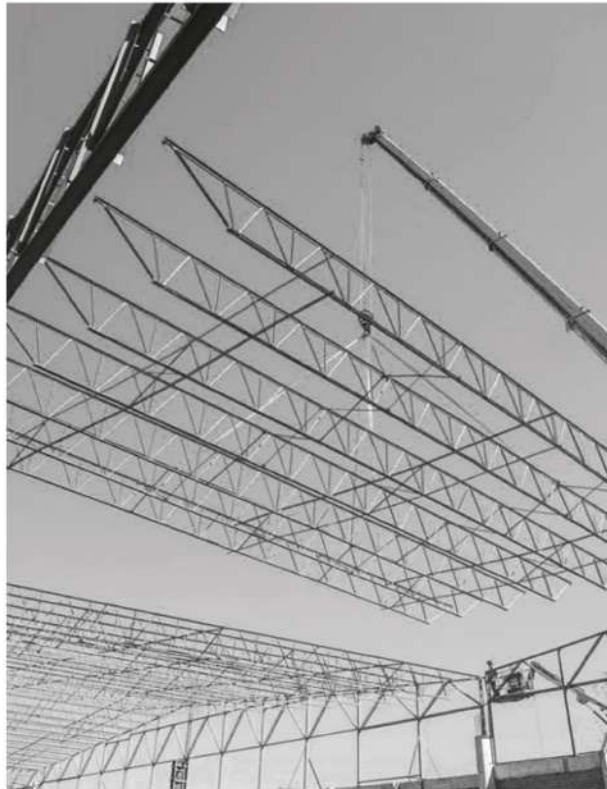
izado de estructura entrepiso
