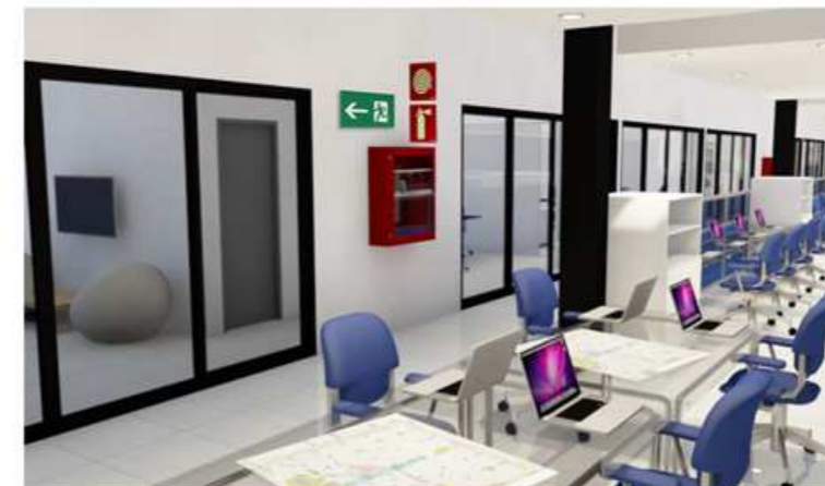
Ubicación de BIE señalizada en planta de trabajo
