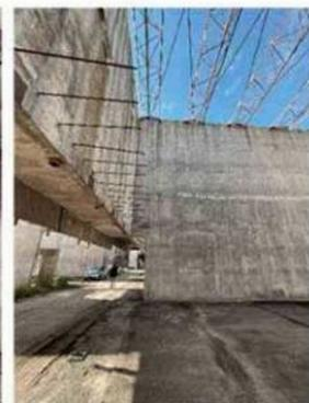
Hierros de estructura expuestos y deteriorados
