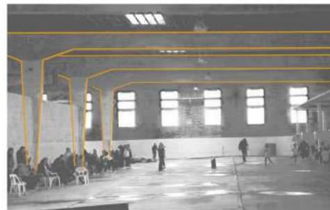
PÓRTICOS DE HORMIGÓN ARMADO
