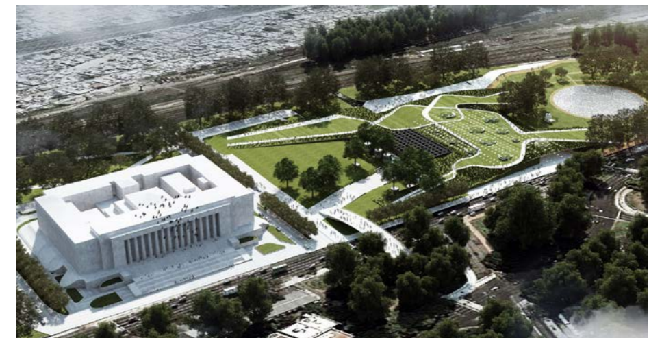
Centro de Exposiciones y Convenciones - C.A.B.A. 2013 - Arq. Edgardo Minond.
