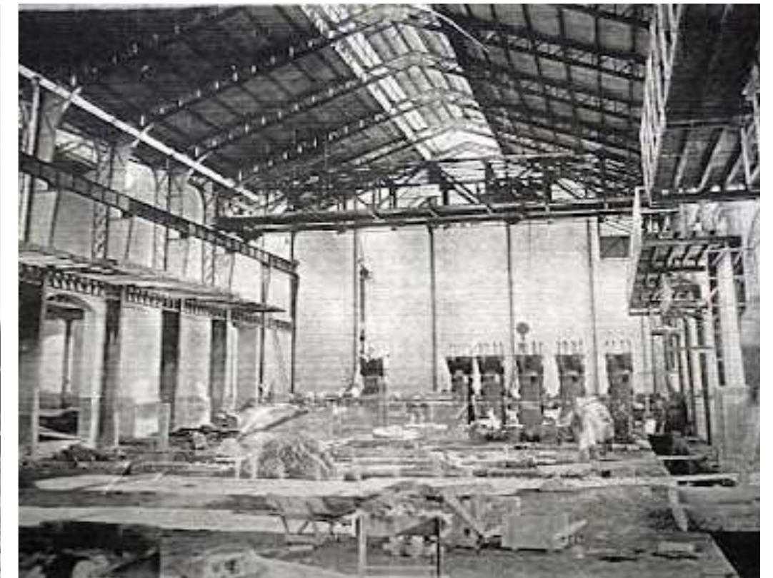
Interior de la nave central
