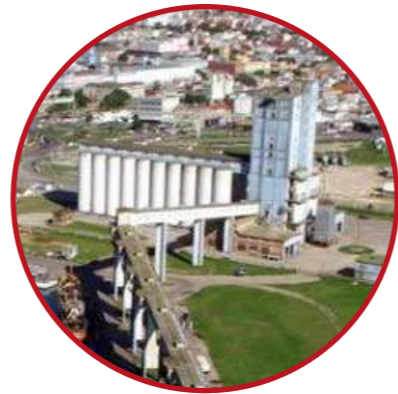
2- Silos Mar del Plata
