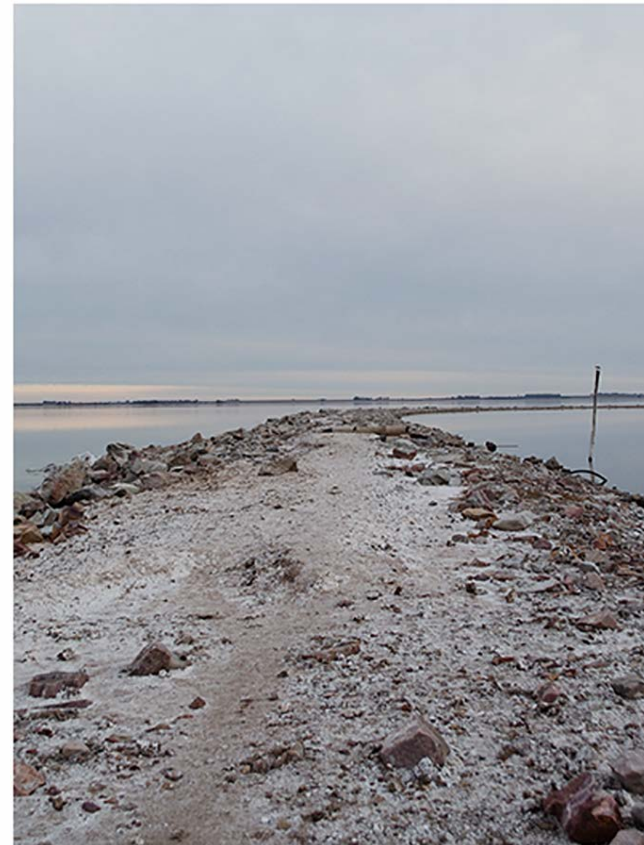
2. La escollera que delimita lo construido de la laguna.
