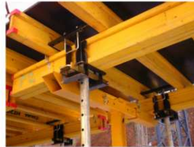
Sistema de apuntalamiento con fenólico con film negro
