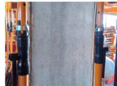
Acabado final del hormigón a la vista
