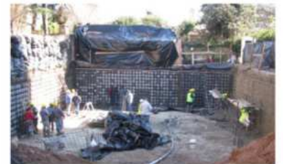
Tabiques de submuración:con discos PRENOVA
