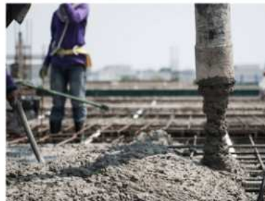
Hormigón elaborado, llenado con bomba y manguera de arrastre
