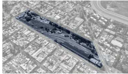
Estación Ferrocarril Roca
