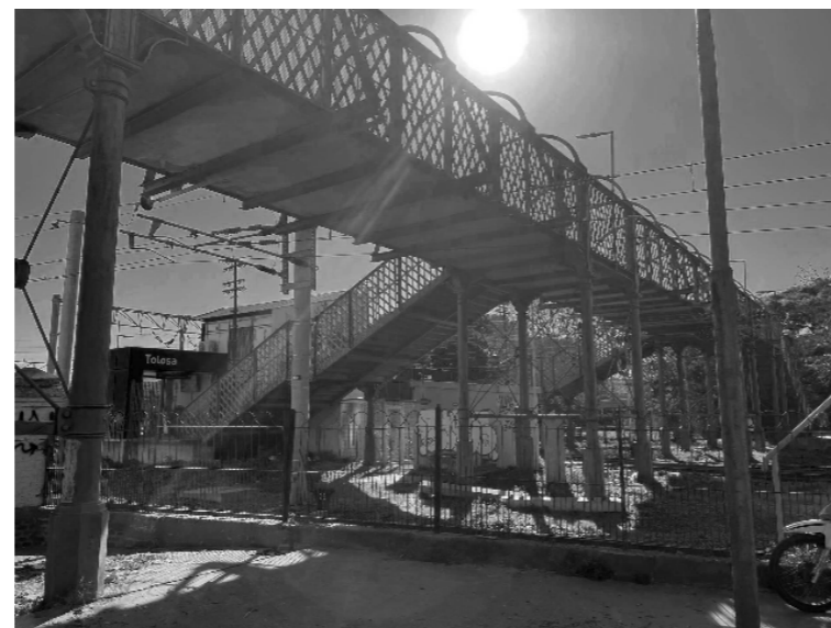
2. PUENTE PEATONAL METÁLICO
