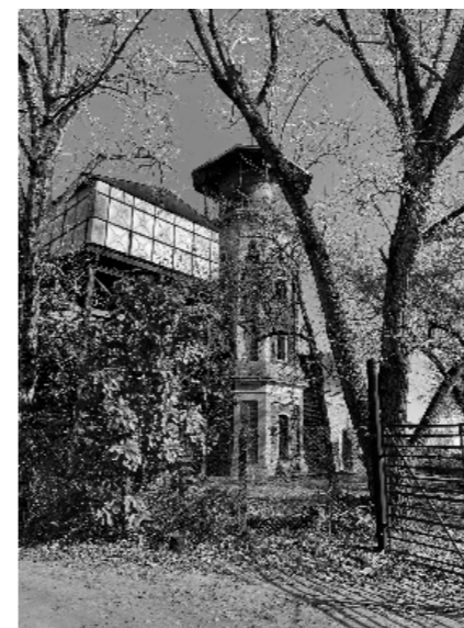
3. MIRADOR Y TANQUE DE AGUA
