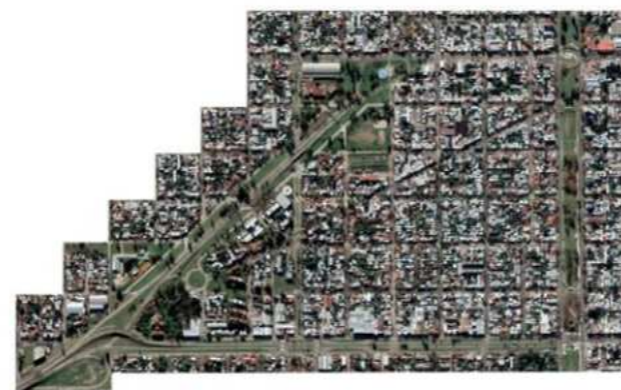
Área de intervención específica
