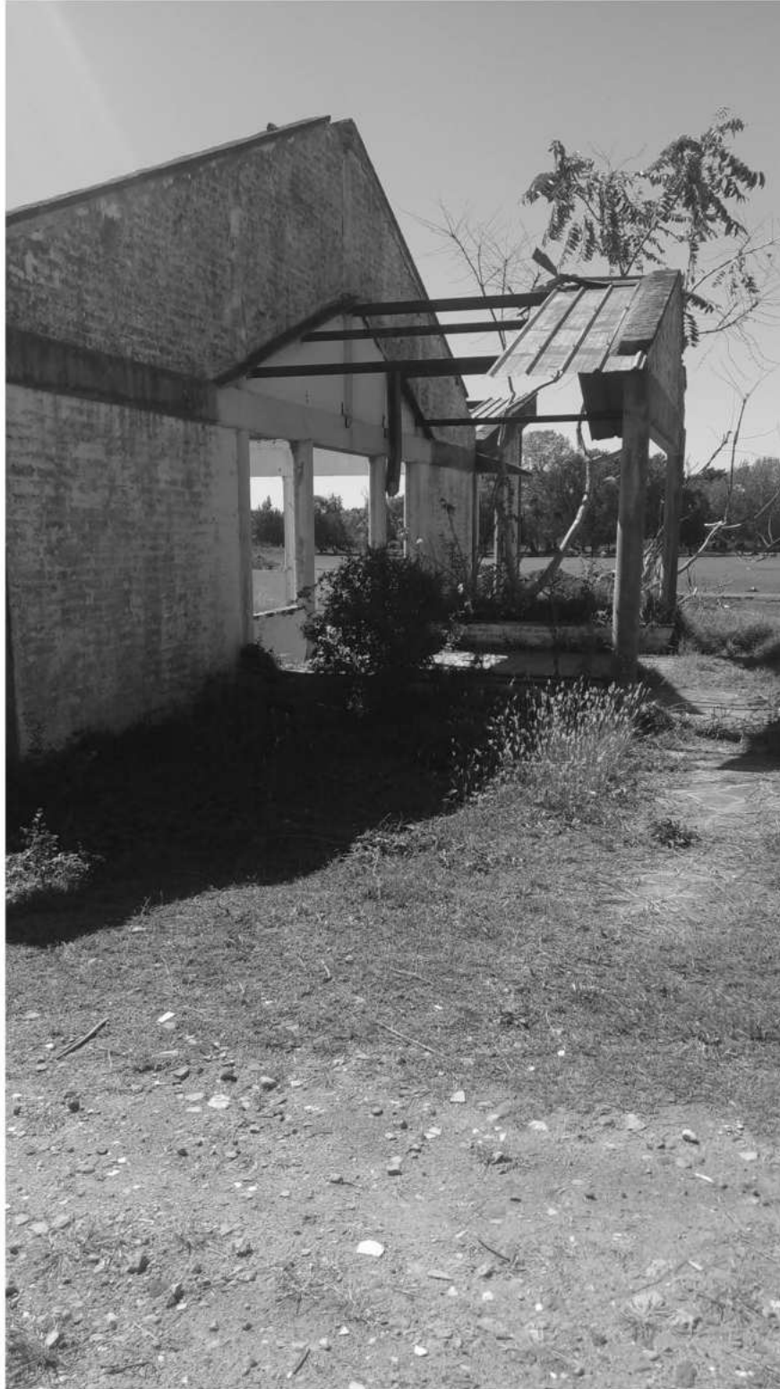
Acceso principal ala preexistencia
