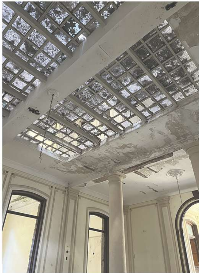
6 - Entrepisos vidriados - combinación de estructuras
