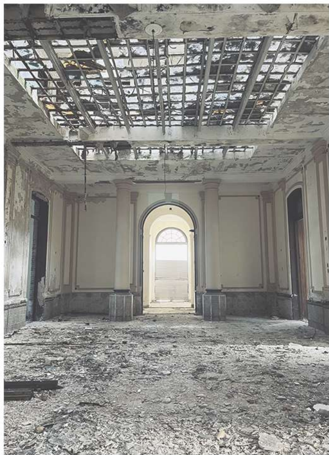
3 - Entrepisos vidriados - espacialidad
