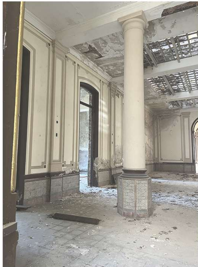
4 - Estructura portante - estructura puntual
