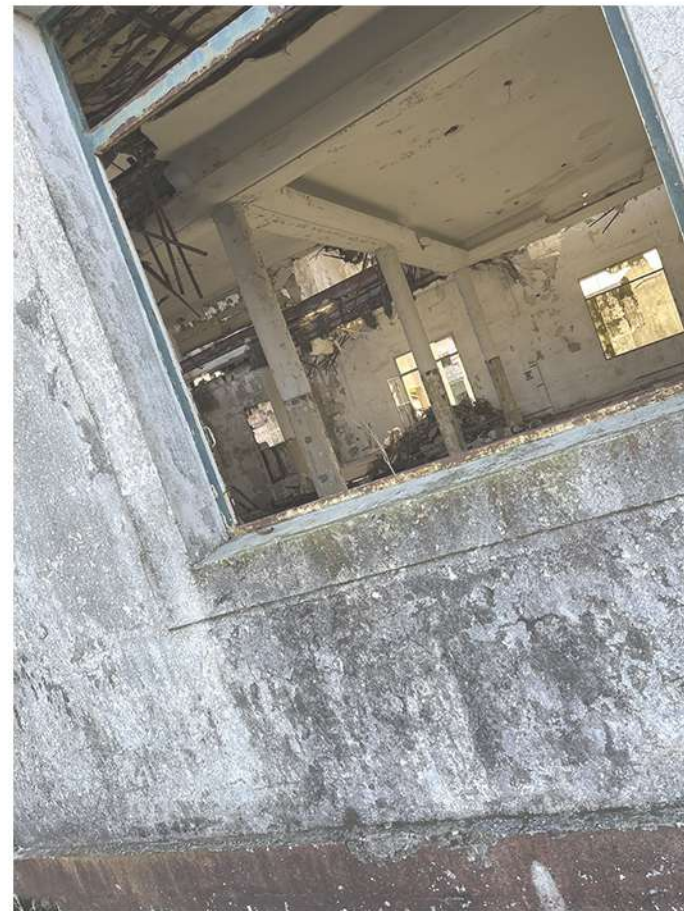
5 - Estructura puntual - columnas H°A°
