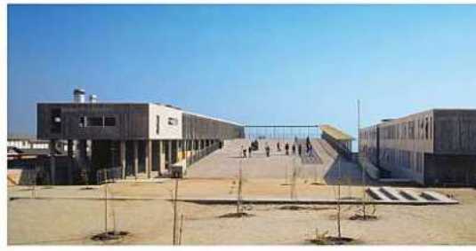
"COLEGIO ALTAMIRA" Chile ARQ. MATHIAS KLOTZ
