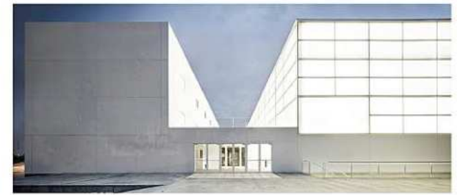
"PABELLON POLIDEPORTIVO Y AULARIO" España ARQ. ALBERTO CAMPO BAEZA
