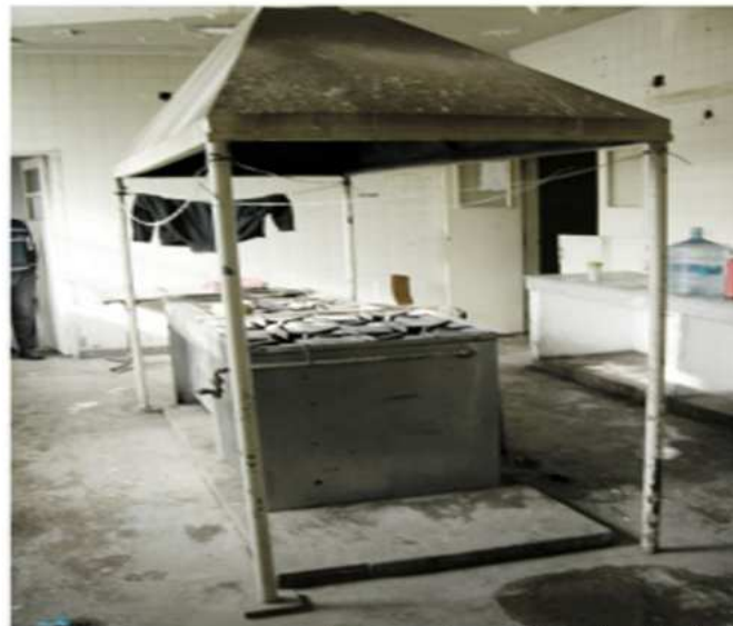
Imagen desde el interior (Cocina)
