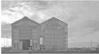
FRAC Dunkerque Lacaton y Vassa
