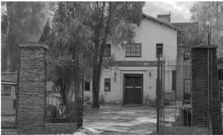
Vista ingreso desde Av.31
