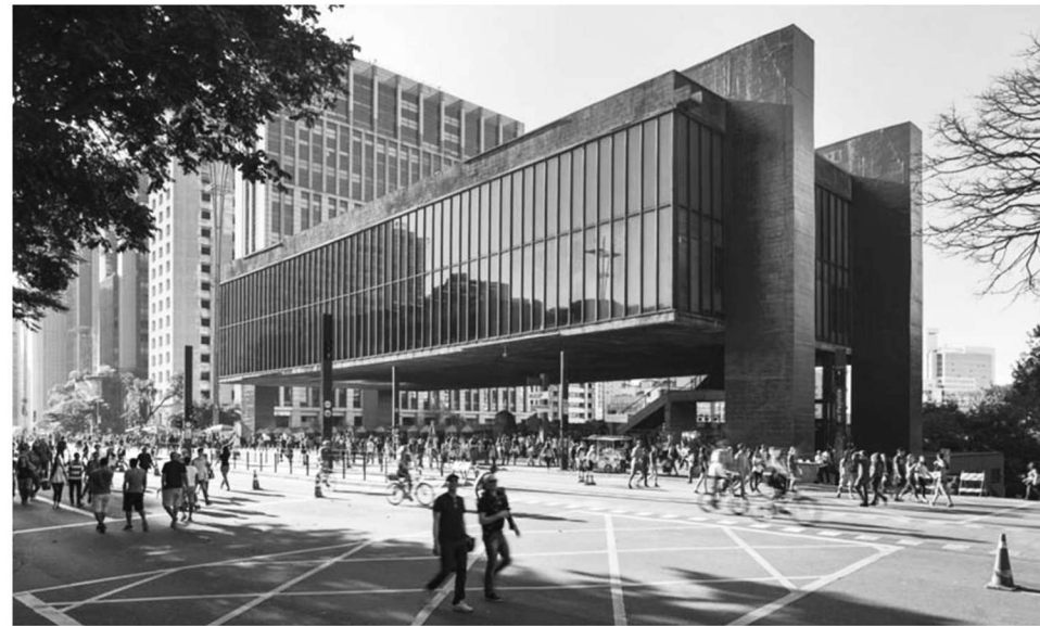
ARQUITECTURA DE ENCUENTRO
