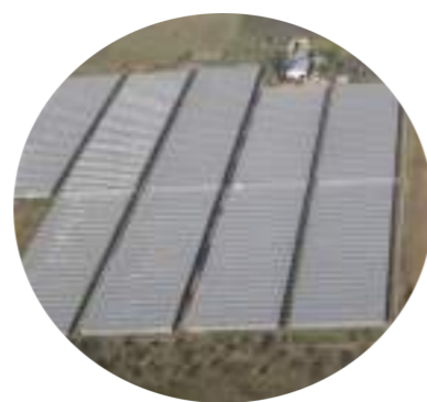
Impermeabilización por invernaderos
