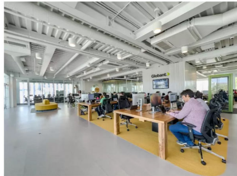
Globant. Marantz Arquitectura, F9studio y Alric Galindez Arquitectos Lenguaje puro Instalaciones a la vista
