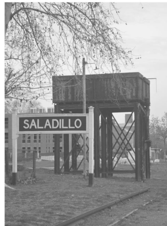
Tanque de Agua
