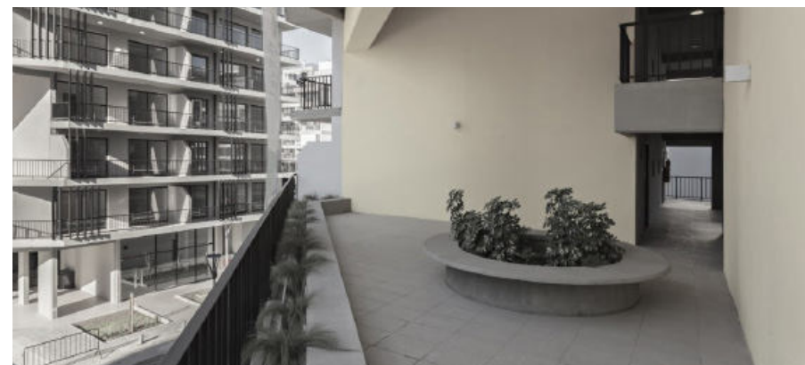
Viviendas colectivas para la Villa Olímpica, smf arquitectos
