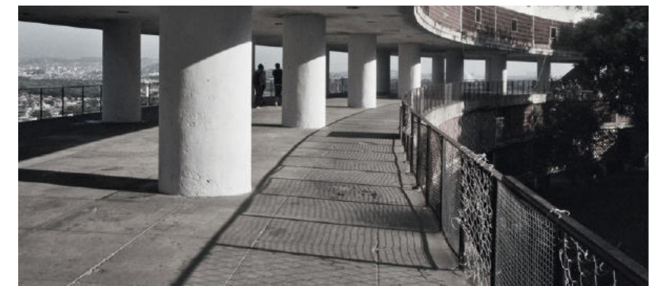
conjunto habitacional pedregulho- rio de janeiro, brasil / alfonso reidy
