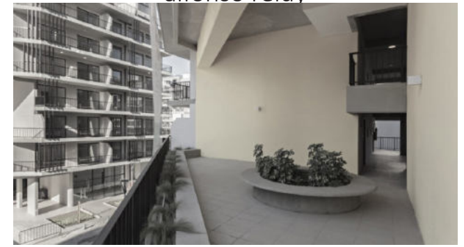
Viviendas colectivas para la Villa Olímpica, SMF arquitectos
