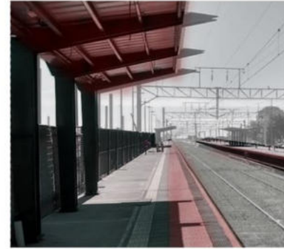
ESTACION DE TREN
