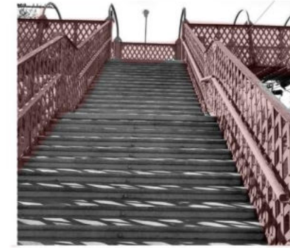
ESCALERAS DE ACCESO
