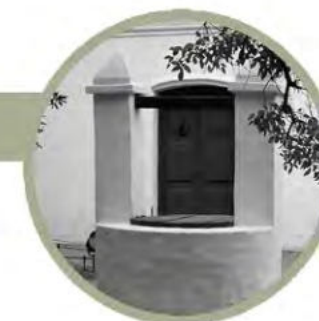
PRIMEROS POZOS DE AGUA 1906
