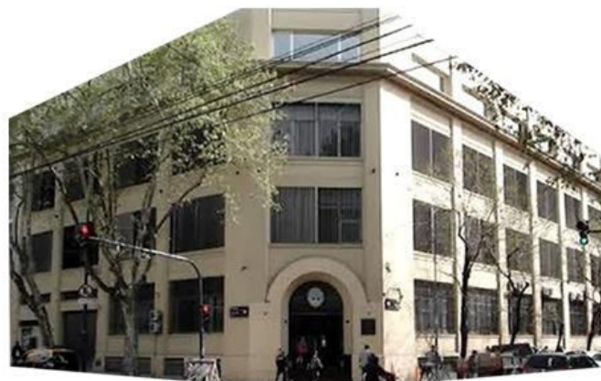
4 - Conservatorio Manuel de Falla
