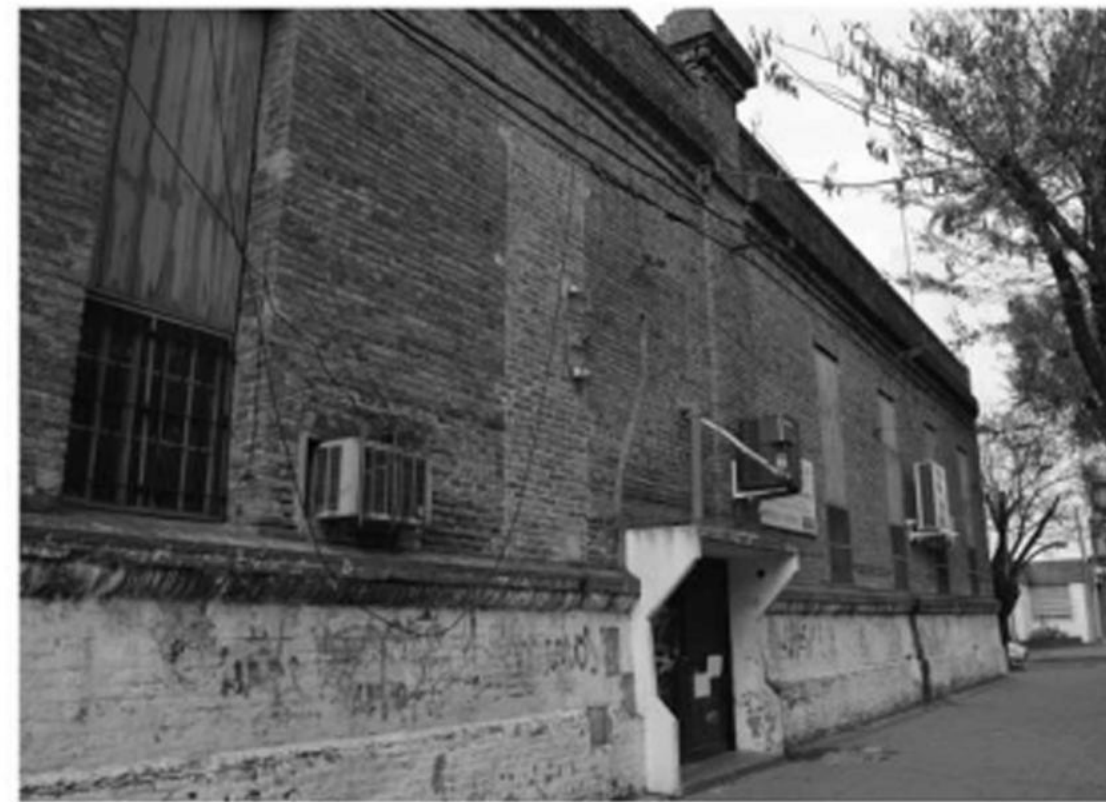
ENVOLTENTE: MURO PORTANTE DE LADRILLO
