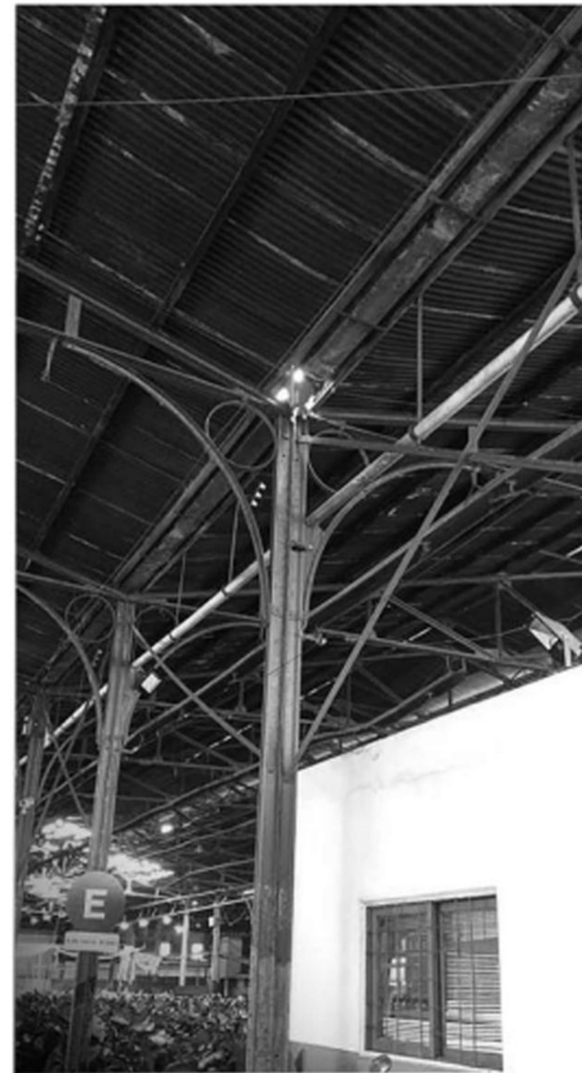
ESTRUCTURA: COLUMNA METÁLICA
