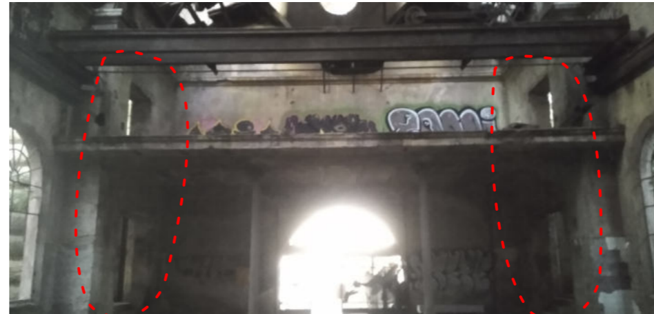
En el ingreso, se aprecia el entrepiso con acceso a través de escaleras que se encuentran en las pilastras. Estas se deberán incorporar para que vuelvan a funcionar y darle acceso al entrepiso y la vista superior de la torre. También verificar la estructura para hacerle tareas de mantenimiento y arreglar el techo).
