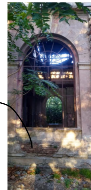
(Ventana exterior para arreglar la carpintería metálica con agregados de vidrio)
