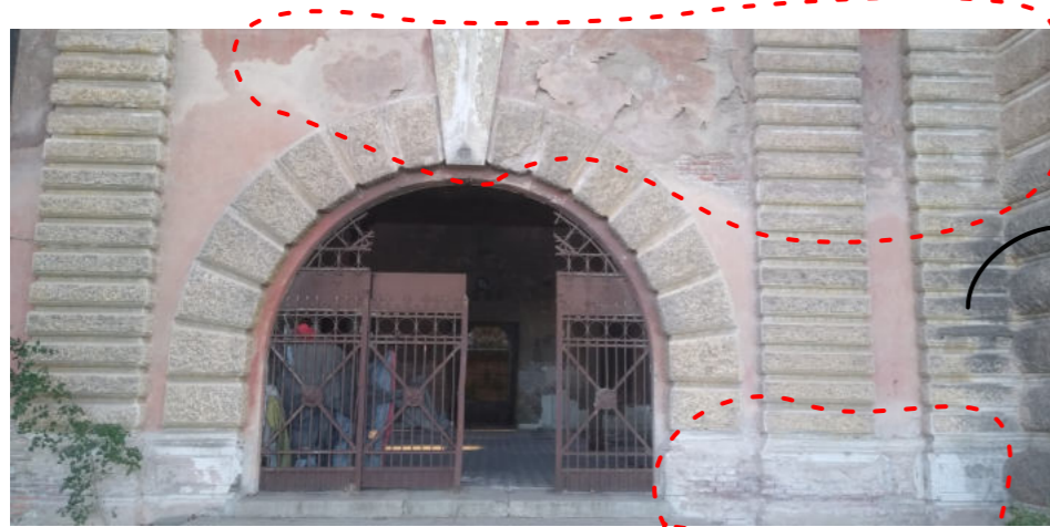
(En la entrada, se observa el deterioro de la fachada, humedad, destrozos de la reja de ingreso. Además del habitar de personas sin hogar en ella por lo que deberíamos reubicar a estas personas y comenzar a arreglar el recubrimiento para volver a aislar todo el edificio).
