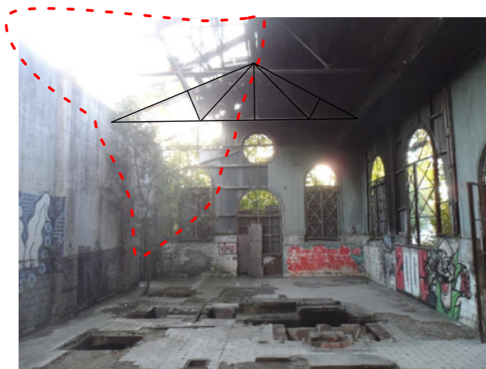
(En el interior de la Usina eléctrica, podemos verificar la falta de partes en su composición por lo que completar esas partes será esencial para su restauración).
