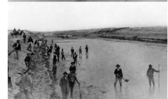
Obreros trabajando en la estructuración del puerto.
