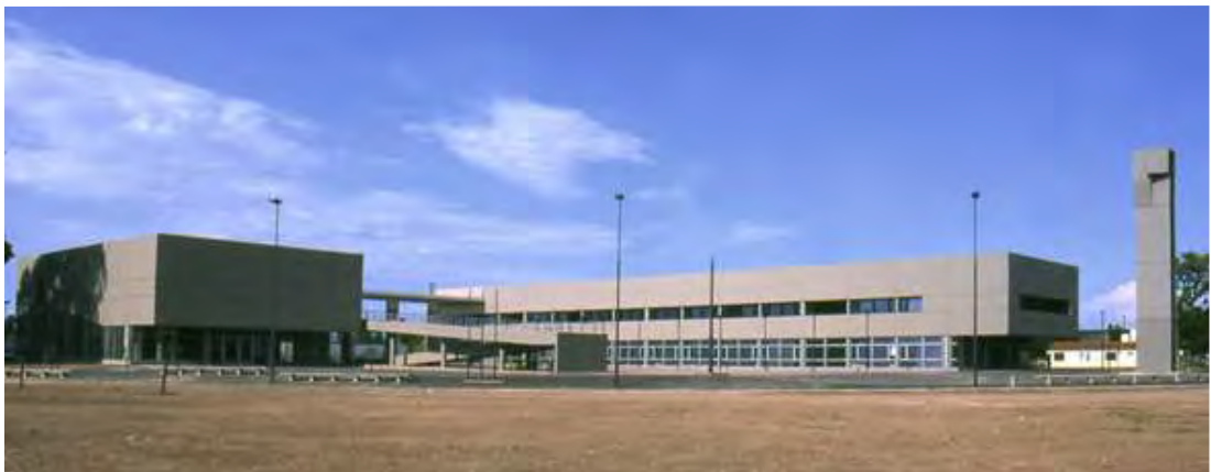
Fig. 6.a y 6.b Centro Municipal Distrito Oeste, Rosario, 1999.
