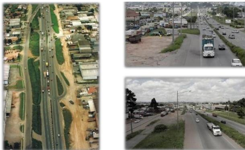
IMAGEN 23. SECTOR INTERVENCIÓN ANTES SE LA INTERVENCIÓN, CURITIBA.
