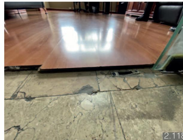
De la misma manera, al interior del edificio, debido a las adaptaciones para los nuevos usos, los pisos han sido reemplazados, como se puede observar en la figura 2.119 al menos por tres capas distintas; incluso en un mismo nivel se evidencian diversos tipos de recubrimientos en fragmentos (ver figuras: 2.118, 2.120 y 2.121).
