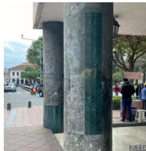
En cuanto a los revestimientos al exterior del edificio, tras la necesidad de colocar anuncios publicitarios en el la fachada frontal del Bloque D, varias piezas de mármol se encuentran agrietadas debido a la inserción de elementos de anclaje aunque estas resulten casi imperceptibles a primera vista, como se muestra en la figura 2.117.
