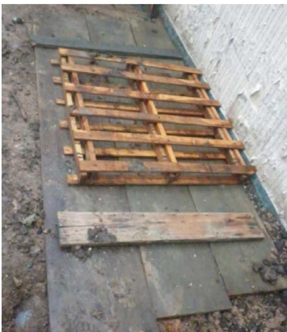
En la imagen se observa el pozo tapado con los tableros, como lo establece la normativa, sobre los cuales se coloca un elemento que evita que el personal transite por sobre los mismos.
