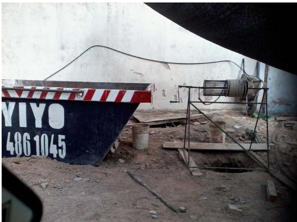
Como se observa en la imagen, los bordes de las excavaciones no se encuentran libres de obstáculos. Los materiales están colocados a 2 metros de distancia de la excavación, pero debido a su peso y la profundidad de la excavación, la distancia debería ser considerablemente mayor.
