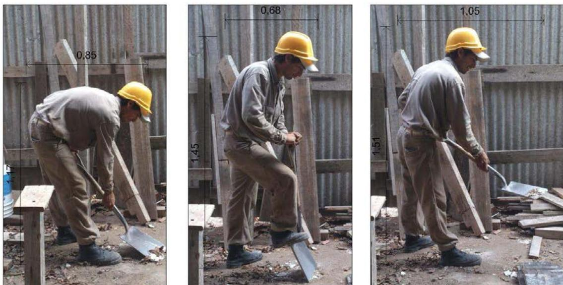
La posición cómoda del levantamiento de la carga sobre la pala requiere 1,05 metros, que son unos 15 cm más que el diámetro del pozo. Es decir, que el movimiento se ve limitado por el espacio de trabajo y genera una incomodidad en la realización de la tarea.
