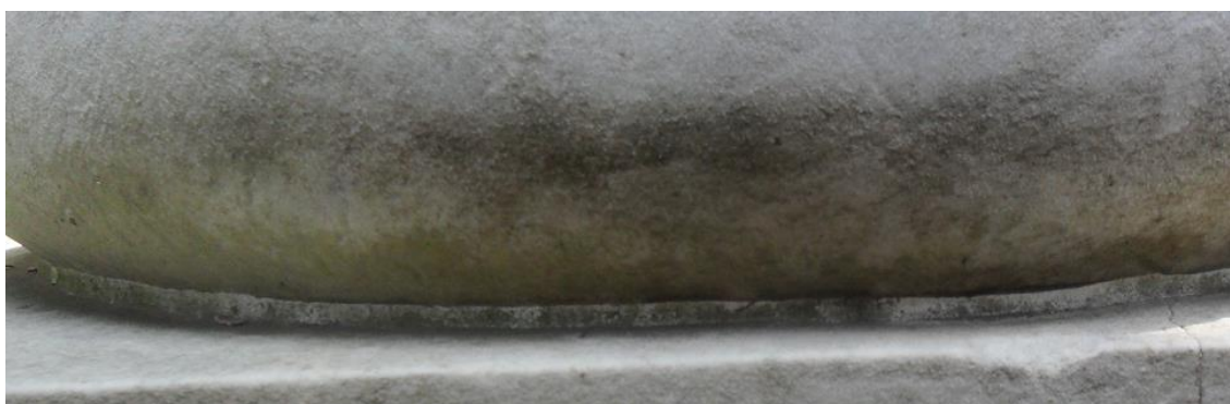
Figura 13. Monumento a Gregorio Funes. Biodeterioro por invasión micro orgánica. Fuente: elaboración propia.
