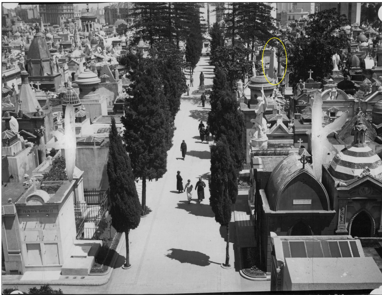
Figura 17. Cementerio panorámica calle central. 1935. AR_AGN_DDF_Consulta_INV: Catálogo general, cajón 12, caja 168, N° 18244.
