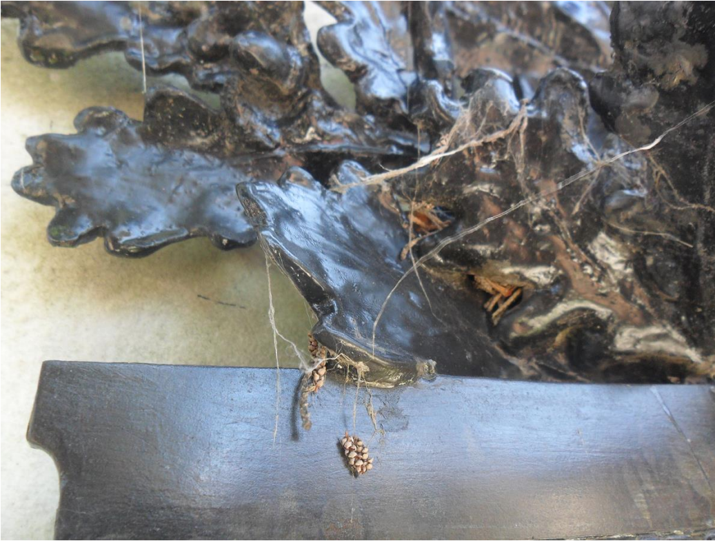
Figura 4. Monumento a Cornelio Saavedra. Material vegetal retenido. Fuente: elaboración propia.
