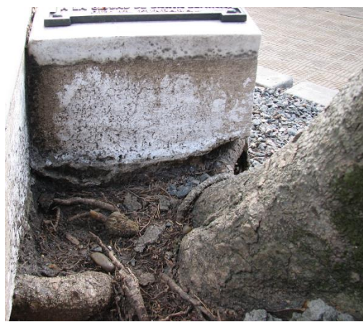
Figura 7 y 8. Raíces de Magnolia penetrando debajo de los monumentos. Fuente: elaboración propia.
