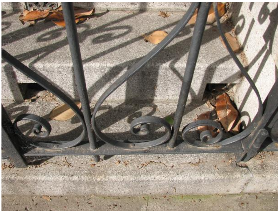
Figura 2. Monumento a Guillermo Rawson. Material vegetal retenido. Fuente: elaboración propia.
