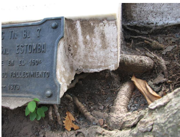
Figura 7 y 8. Raíces de Magnolia penetrando debajo de los monumentos. Fuente: elaboración propia.
