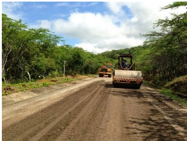
Fotografía 29. Proyecto de construcción autopista.
