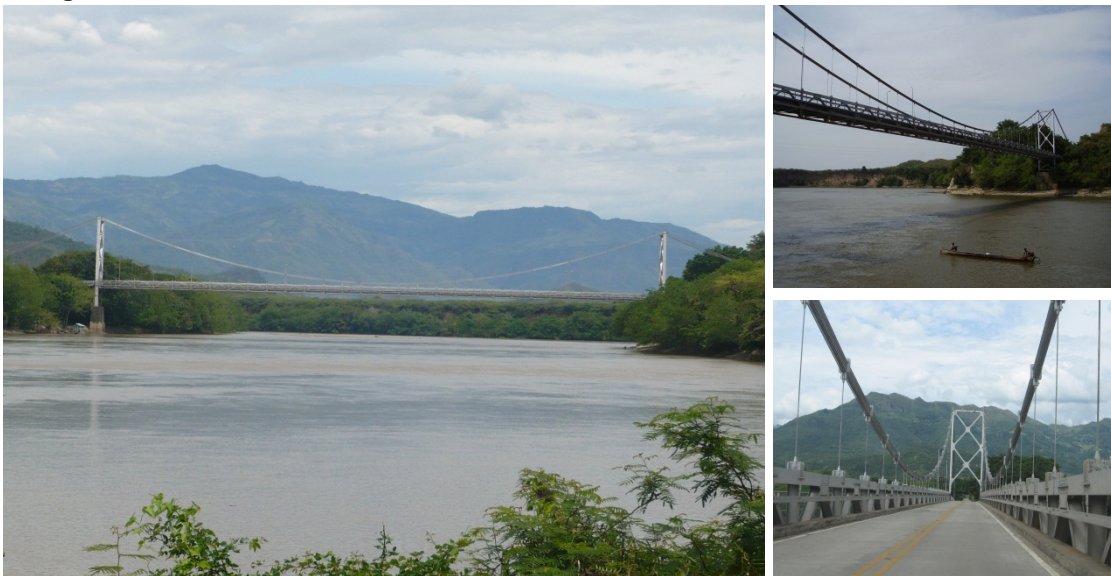
Fotografía 6. Puente “La libertad”.
