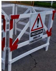
Fijación de señales a las vallas
