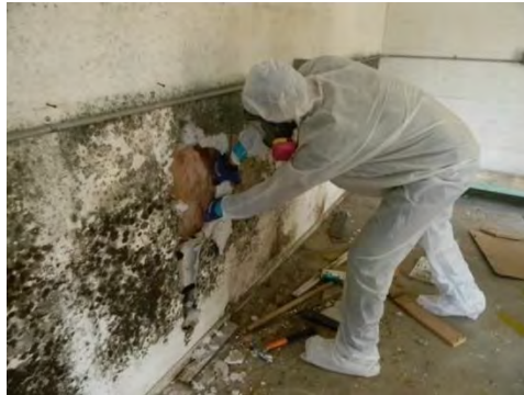
Figura 38: Remoción de moho negro tóxico.
