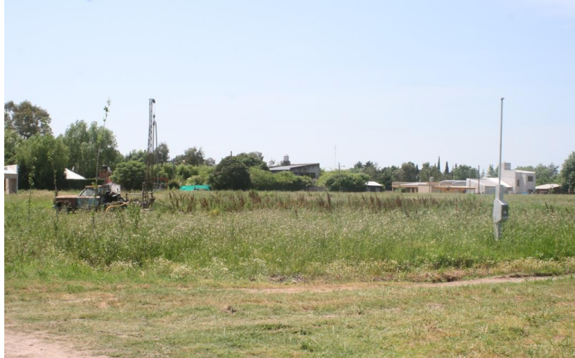
En la imagen se puede apreciar la máquina perforadora y el poste de luz para la futura construcción. Una planificación urbana que poco o nada tiene de sustentable. Imagen Propia
