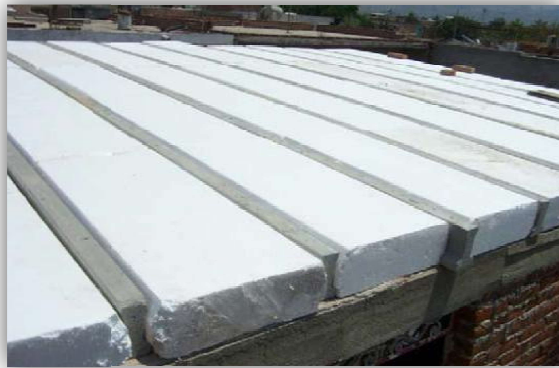
Imagen 15: Vista de bloques de poliestireno expandido y viguetas.
