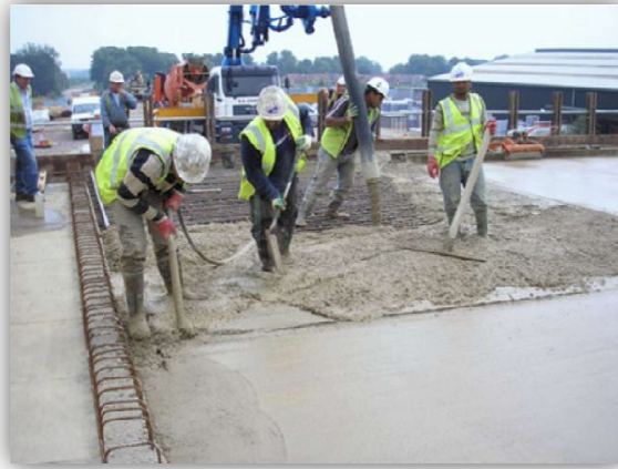
Imagen 16: Hormigonado sobre estructura de viguetas y bloques.
