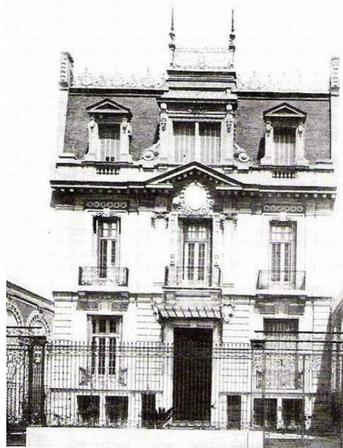
Vivienda unifamiliar para Antonio Lanusse, obra del Arq. Luis Dubois.
