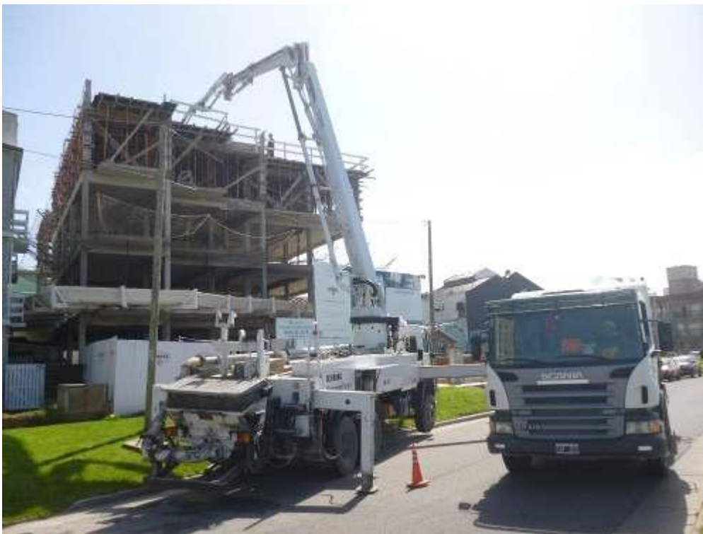
Imagen 24: hormigonado con pluma. Fuente: http://transgrues.blogspot.com.ar/
