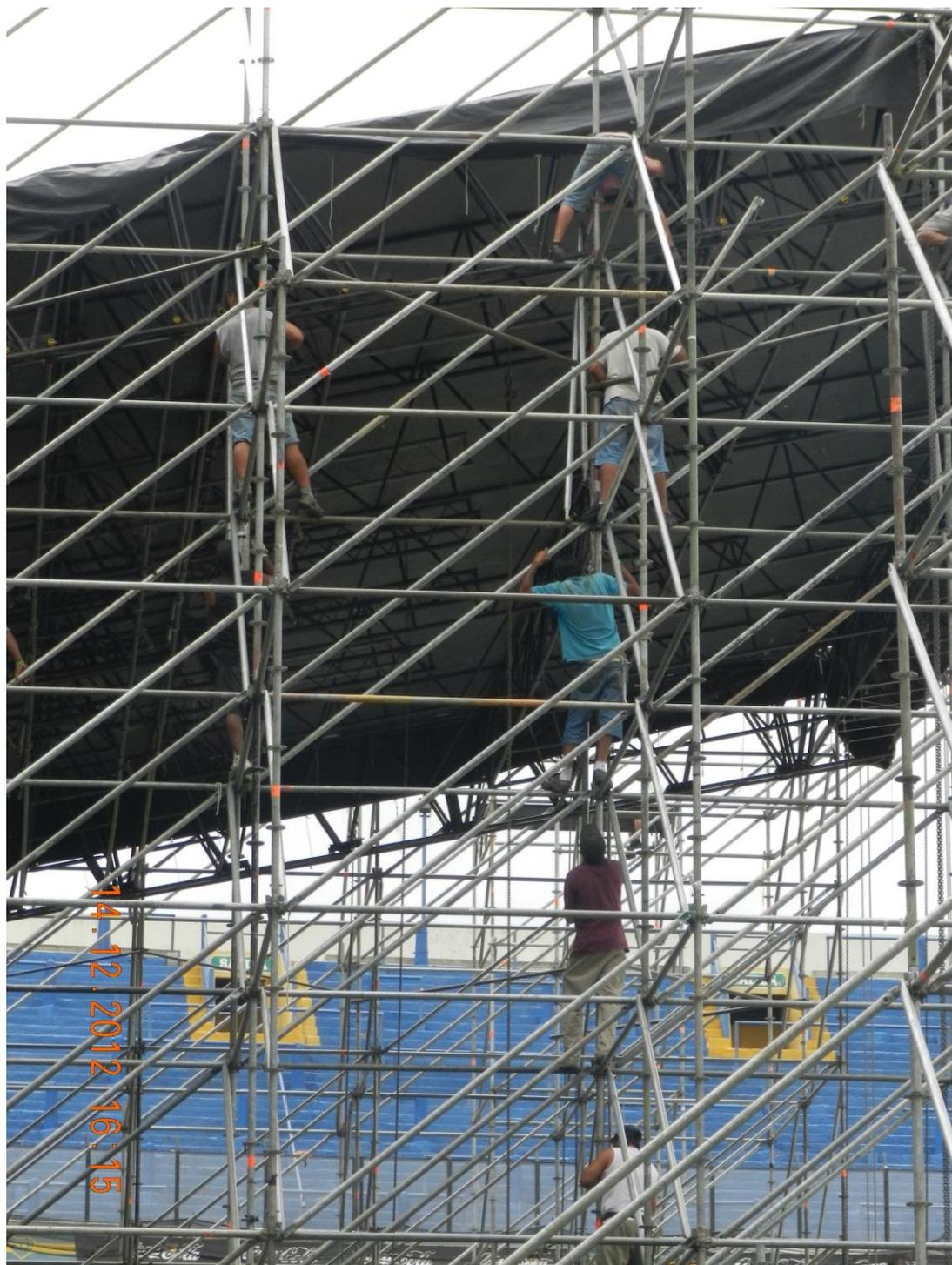
Imagen 22: Trabajadores elevando las piezas de estructura tubular metálica
