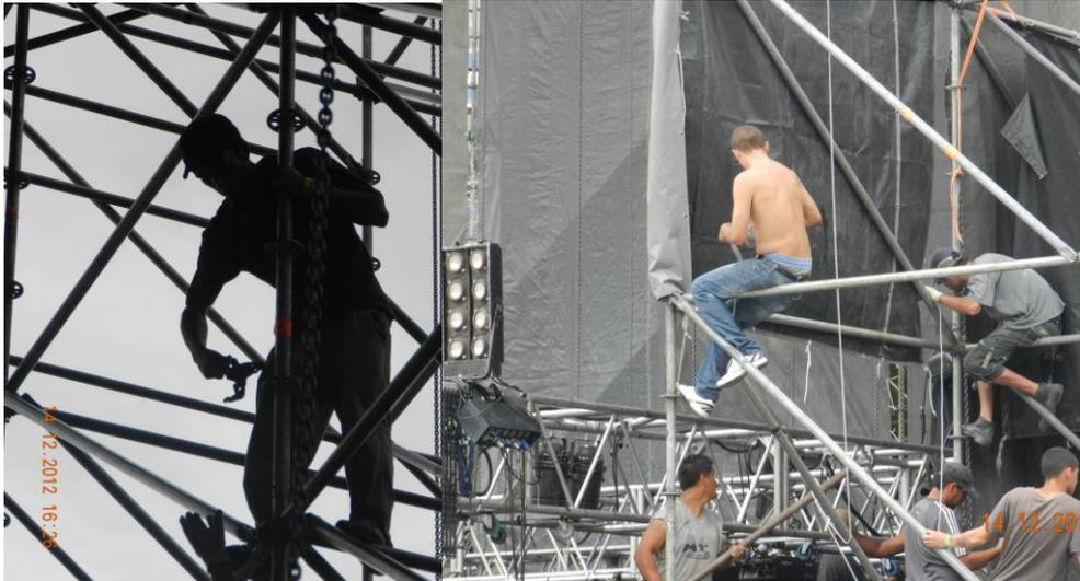
Imagen 23: Trabajadores ajustando las piezas tubulares con herramientas manuales
