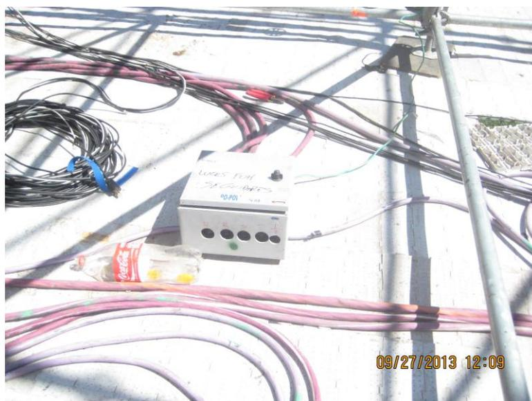
Imagen 26: Cableados sin tendido de jabalina de puesta a tierra y expuestos a la intemperie sin protección
