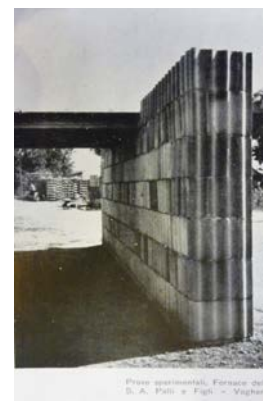
Prueba experimental del ladrillo Palandomus en los Hornos de la S.A. Palli e Figli, Voghera. Ca. 1939. Mario Palanti Palandomus, case per il popolo, ca. 1948
