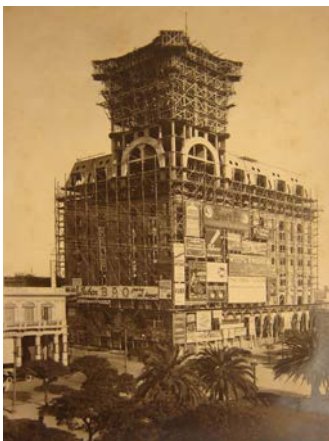
Secuencia de la construcción de la estructura de hormigón armado del Palacio Salvo (1923-1928), Montevideo. Arq. Mario Palanti, Ing. Gori Salvo, Empresa Constructora Dickerhoff & Widmann. Mario Palanti Papers, GRI. Los Angeles.
