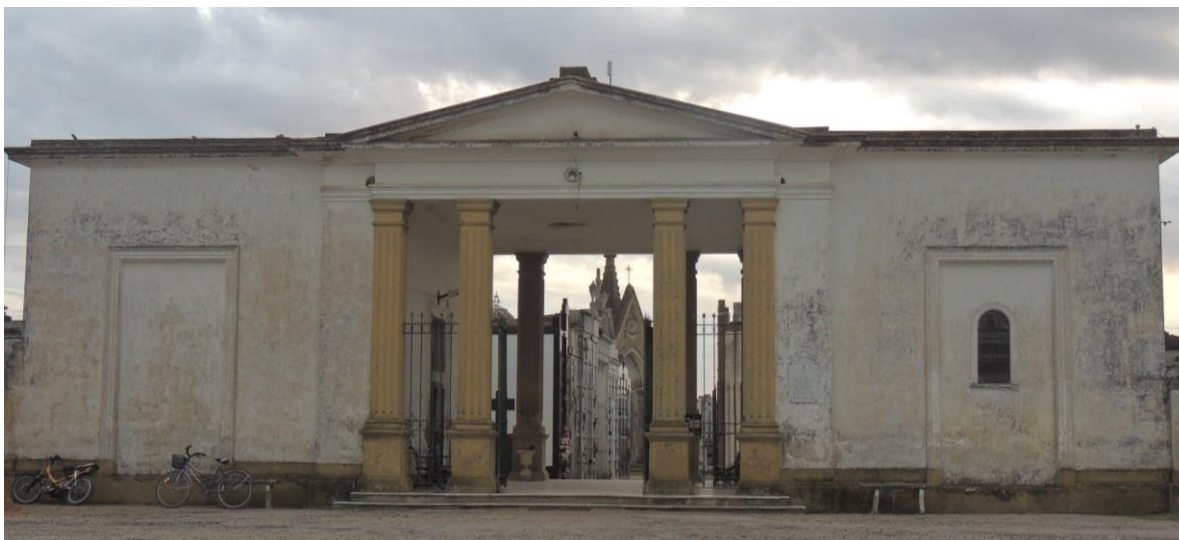
Figura 5.A. Fachada del Cementerio Municipal de Magdalena.
