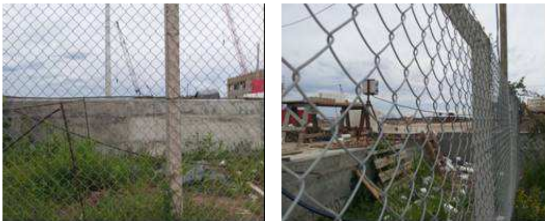
Figura 58. Área donde funcionaba el frigorífico Armour. Se pueden apreciar, no solo su inexistencia absoluta (producto de su demolición), sino el grado de modificación y transformación que responde a otro proyecto que nada tiene que ver con la historia del lugar. Entre las imágenes, se observan usos, levantamiento del terreno, negación con la identidad del lugar y la dificultad de observar el río. En síntesis, no responde a ningún proyecto paisajístico.
