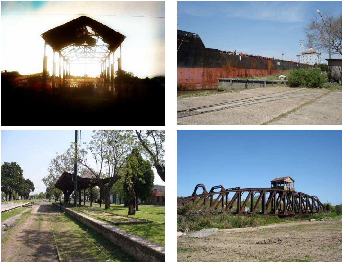
Figura. 50. Diferentes infraestructuras asociadas a la funcionalidad productiva-explotativa. Vieja estructura en pié, embarcación abandonada, línea férrea de estación Circunvalación y el puente giratorio. Fuente: Margueliche, Juan Cruz
