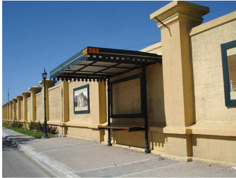
Figura 45. Zona portuaria de Ensenada. Se mantiene la estética aportando elementos que recuerden la identidad del lugar. Coexiste la identidad y la funcionalidad (parada del colectivo Línea 202).
