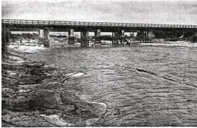
PUENTE DE MADIERA, de 70 metros de luz, sobre el arroyo El Taba, en el cruce de Vera a Reconquista.
