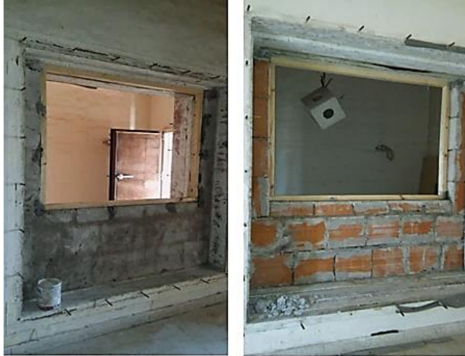
Figura 109 Construcción de pared para la inserción de la muestra
