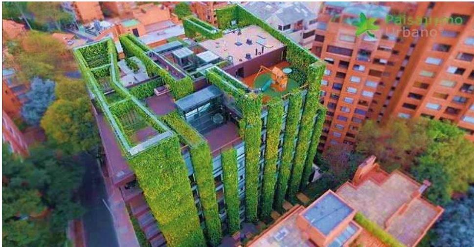
Figura 27 Edificio Santalaia (Biólogo Solano Cabello, Bogotá, 2016)
