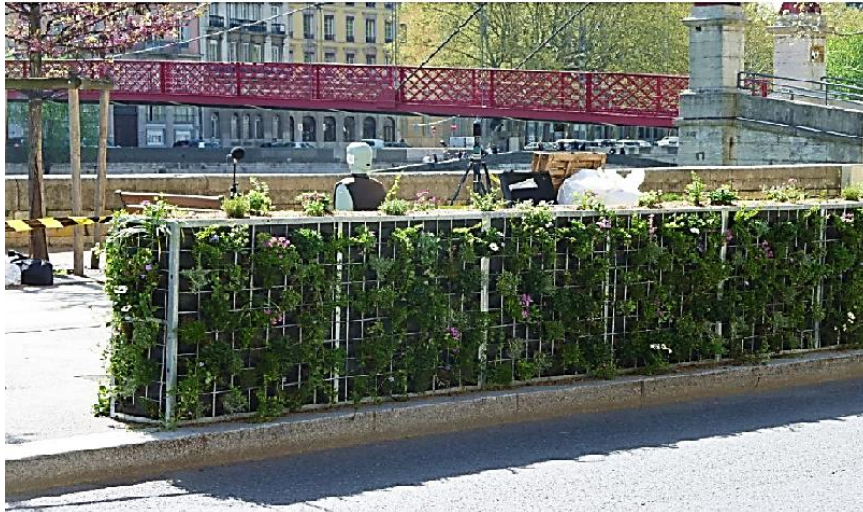
Figura 91 Barreras bajas divisorias entre carriles de tránsito
