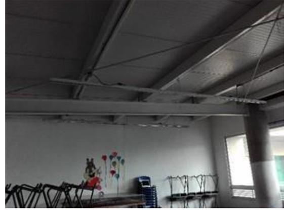
*Figura 7-9: Cubierta en placa delgada a la vista,
