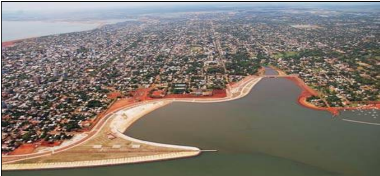
Foto N° 45: Tratamiento Costero en ejecución – Sector Bahía El Brete - Ciudad de Posadas (Argentina)
