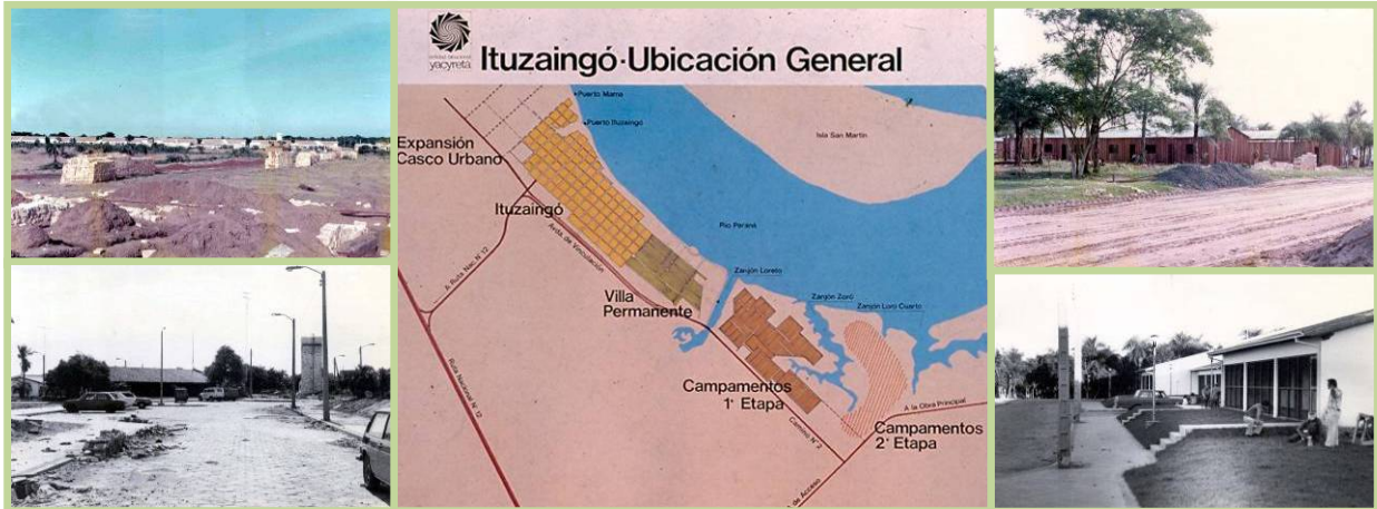
Imagen N° 9: Construcción de la Villa Permanente y Temporal – Ituzaingó, Argentina, 1979
