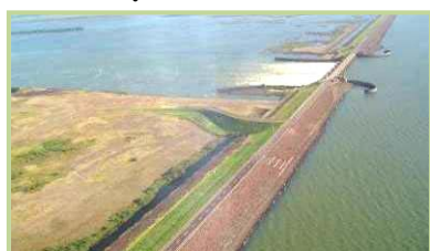
Fotos N° 49 y 50: Presas de Tierra
