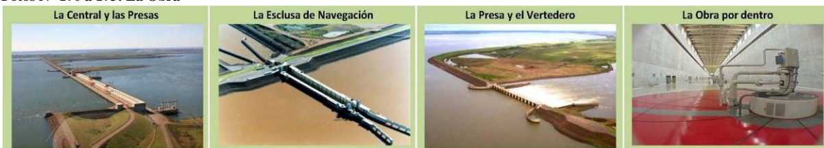
Fotos N° 170 a 173: La Obra
