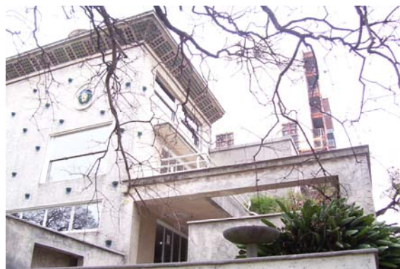
Fachada sobre calles Domingo Cullen.
