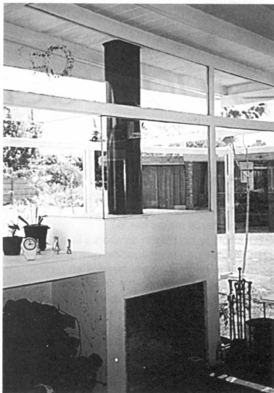
Detalle del muro inclinado de la fachada
