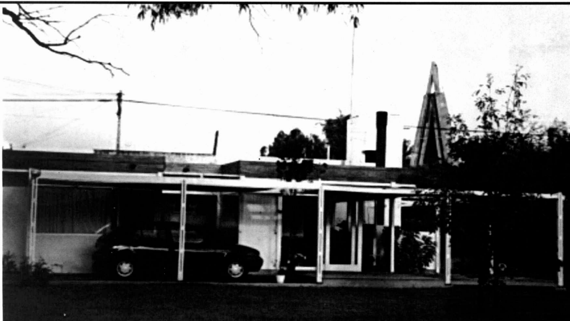
Fachada sobre calle 27
