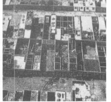
La construcción continuada en lotes.
