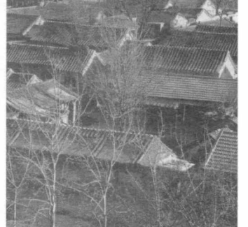
Casa Patio. Complejo residencial, Peking.
